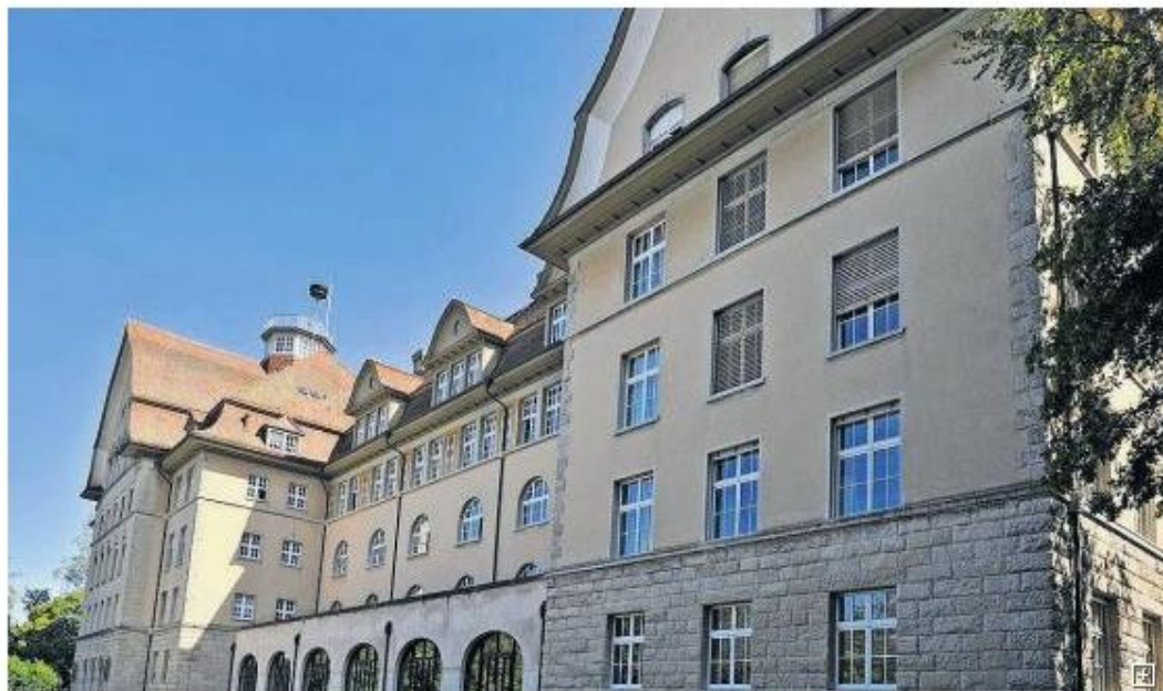
Das Hauptgebäude der Kantonsschule Frauenfeld. (Bild: Reto Martin)
